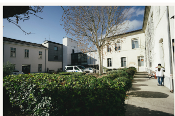
Site de Pertuis 58 Rue de Croze
